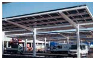
Ein zentrales Element der Neugestaltung ist der neue Carport mit integrierter Photovoltaikanlage, die jährlich rund 400.000 Kilowattstunden Strom erzeugt. Parallel dazu wurde auch das Dach des Einrichtungshauses mit einer weiteren PV-Anlage ausgestattet, die mit rund 800.000 Kilowattstunden pro Jahr die doppelte Leistung aufweist. Gemeinsam erzeugen die beiden Anlagen rund 1,2 Millionen Kilowattstunden Strom – ein Großteil davon wird direkt am Standort verbraucht.
