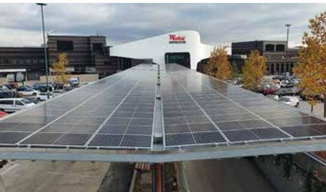
Das Dach des Übergangs von der Badner Bahn Station zum Eingang 5 wurde mit PV-Paneelen bestückt.
